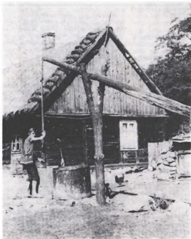
Pōdla nowych statokow nadeńdžeš w Pōlskej tež zajimawe stōmjane trěchi.
