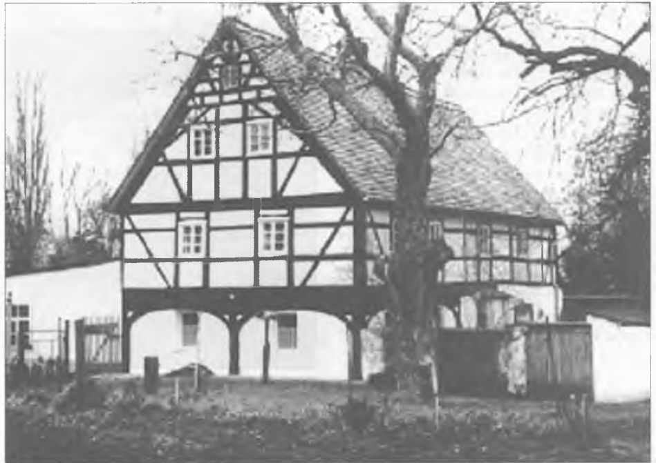
Žiwnosć Pětra Mlónka w Džiwočicach, na kotrejž bě wón wot lěta 1821 do lěta 1867 z hospodarjom, je rjany a derje zdžeržany architektoniski ensemble ze spočatka 19. lětstotka. Twarjenja steja pod škitom pomnikow. Blisko při žiwnosći je něhdy stat mały domček, w kotrymž bydleše Pětr Mlónk wot lěta 1867 hač do smjerće 1887 na wuměnk.
