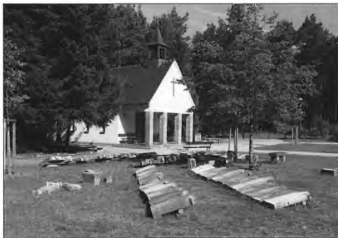
Na nětčišim pohrjebnišću w Rownom rozpołożene narowne kamjenje stareho Rownjanskeho pohrjebnišća Foto: T. Malinkowa
