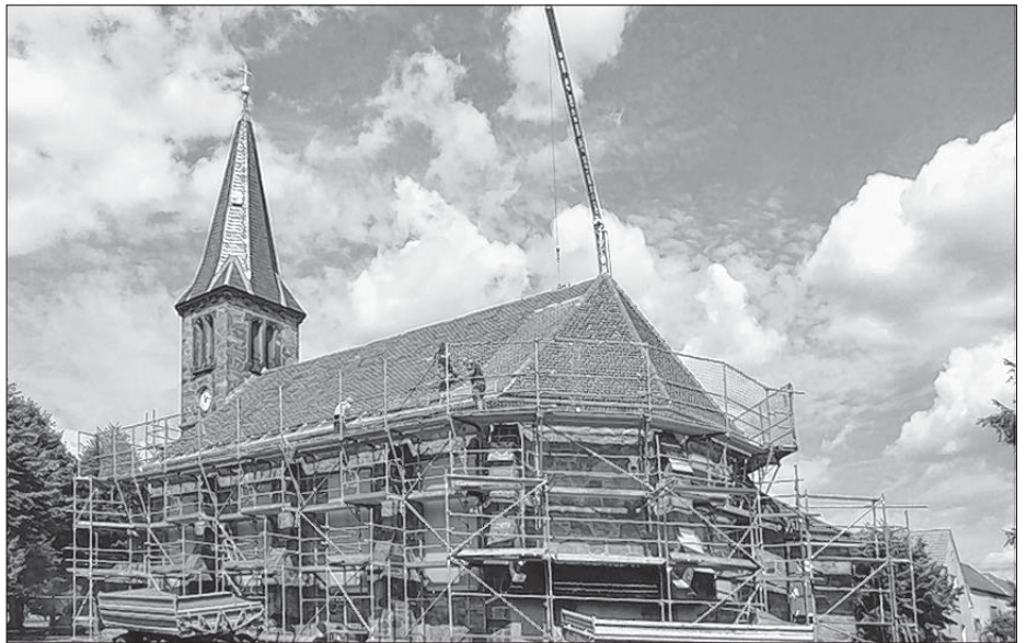
Kónc junija lońšeho lěta zahajichu so twarske dźěla na Łupjanskej cyrkwje ze zaroštowanjom twarjenja a wotkryćom stareje třěchi. Wosadni při tym pomhachu. Foto: T. Bejmakowa
